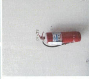
ถังดับเพลิงชนิดผงเคมีแห้ง (Dry Chemical Extinguishers) ใช้
