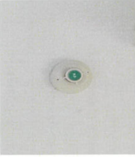
อุปกรณ์ตรวจจับความร้อน (Heat Detector) จัดเป็นอุปกรณ์เริ่ม
